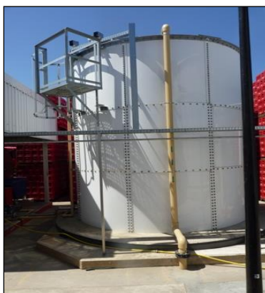
Figura 14: Tanque de lamas
