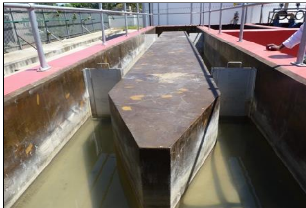
Figura 7: Canal de entrada do efluente bruto
