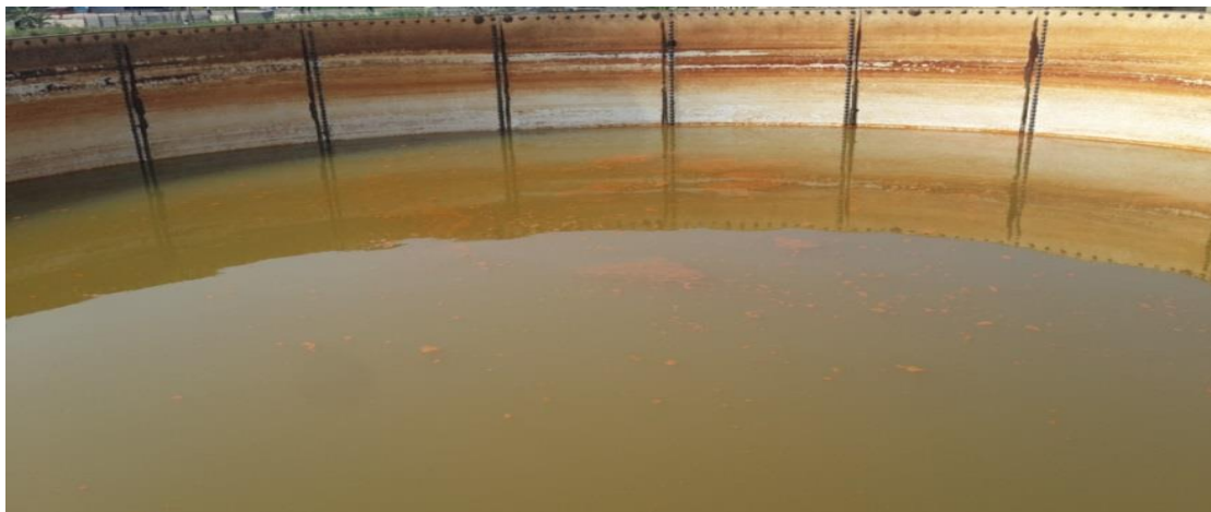
Figura 12: Tanque de equalização – EQ
