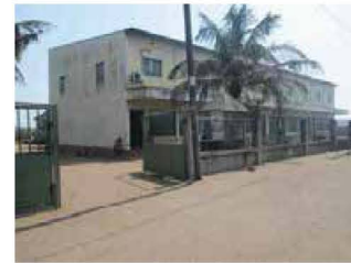
Materiais de Construção
