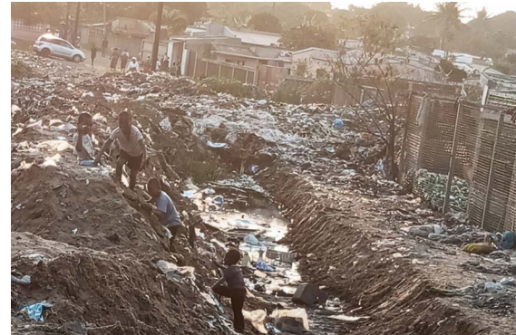
6. VALA DE DRENAGEM
