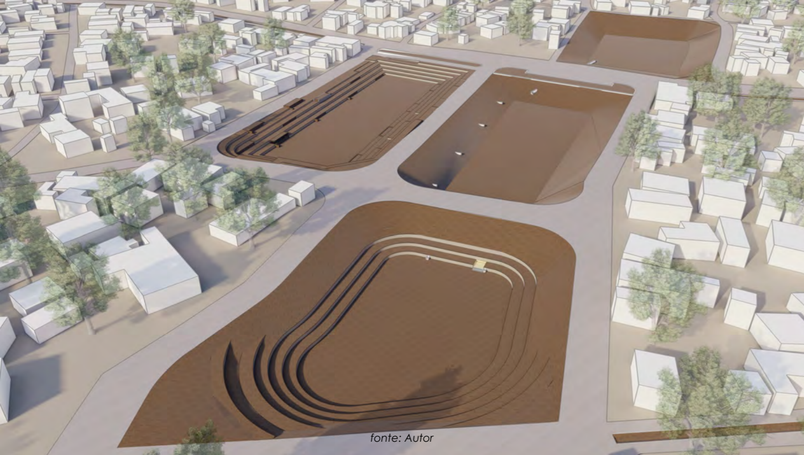
FIGURA 105. Escavação do terreno para construção das bacias é instalado tubos de betão de 600mm para drenagem das águas pluviais
