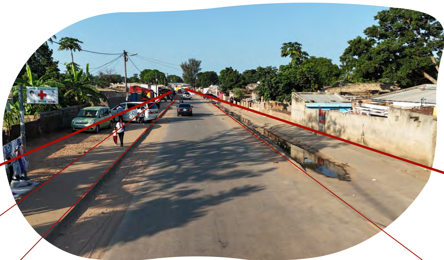
FIGURA 123. Situação actual da zona de intervenção para algumas vias
