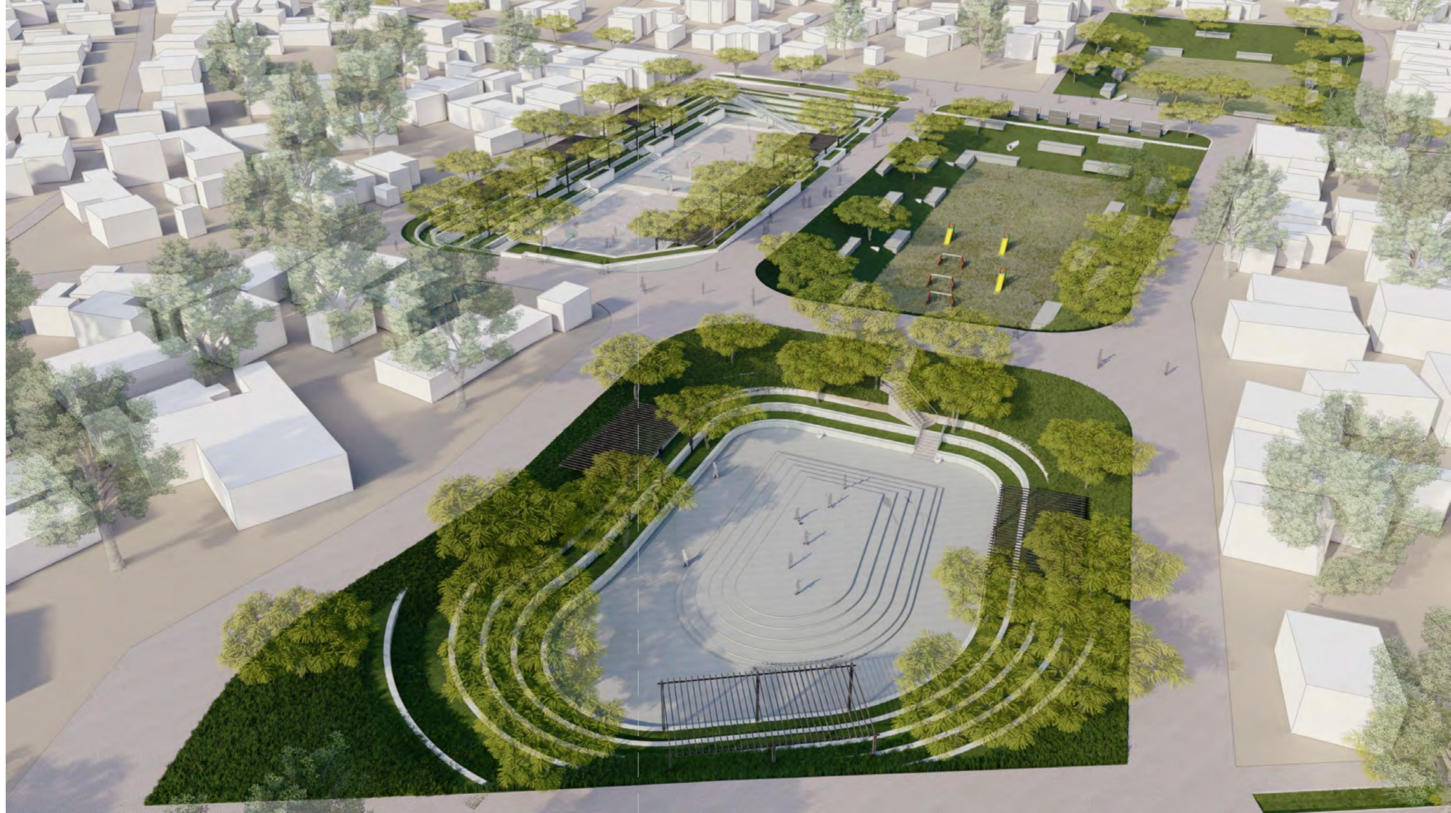
FIGURA 109. Bacias de retenção e infiltração fonte: Autor
