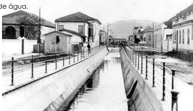
FIGURA 13. Canal de drenagem de Santos/SP no início do século XX. Fonte: Pereira (2006)
