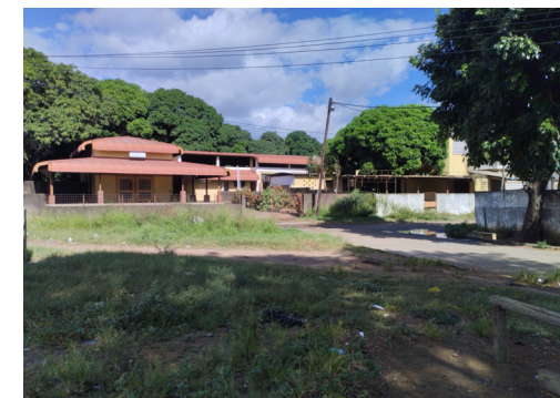
Figura 49 - Entrada da casa mortuária. Fonte: Autor
