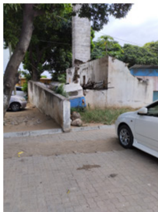
Figura 63 - Antiga incineradora de resíduos
