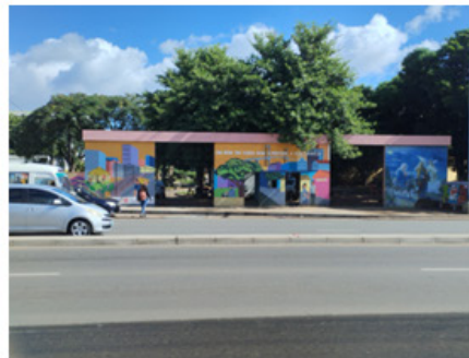
Figura 60 - Vista externa do muro de vedação no antigo portão de entrada actualmente fechado
