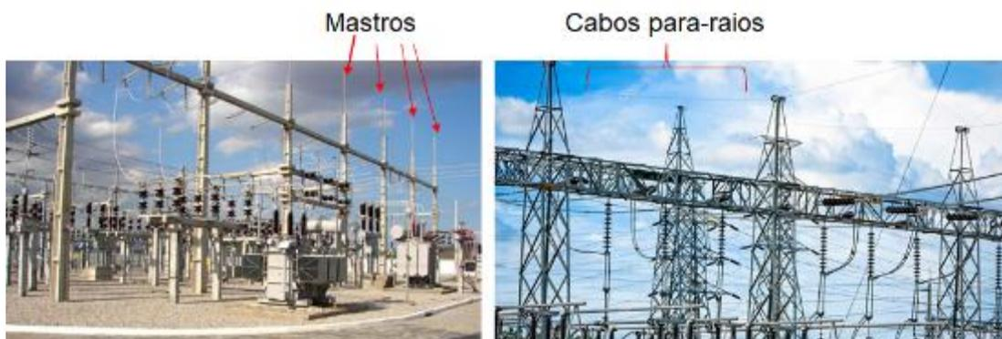
Figura 6: Monitoramento ambiental de uma subestação eléctrica. Fonte: [18]
