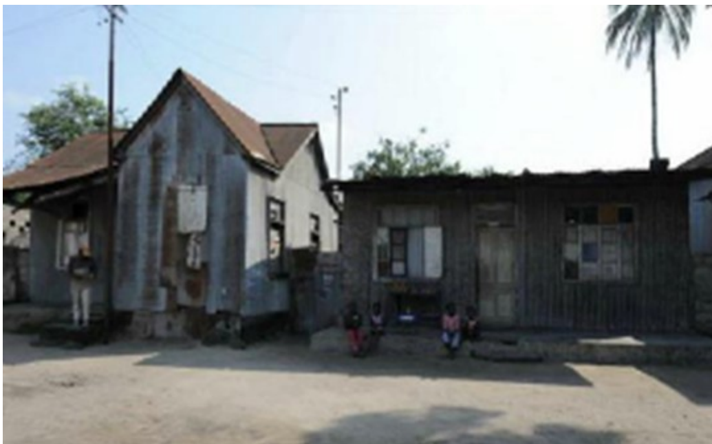
Figura 5: Habitação construída em Zinco e Madeira, Chamanculo. (Fotografia: Laranjeira 2016)
