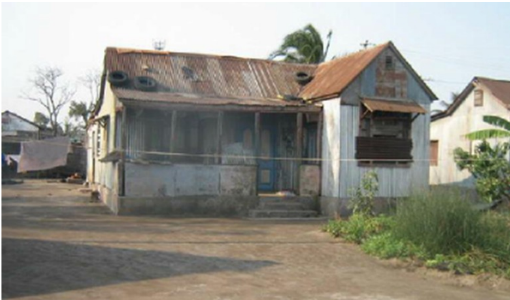
Figura 4: Habitação construída em Zinco e Madeira, Chamanculo. (Fotografia: Laranjeira 2016).
