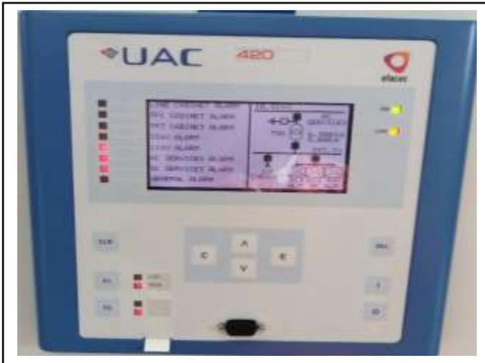
Figura 17: Relé de proteção.
