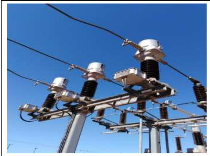
Figura 16: Transformador de corrente
