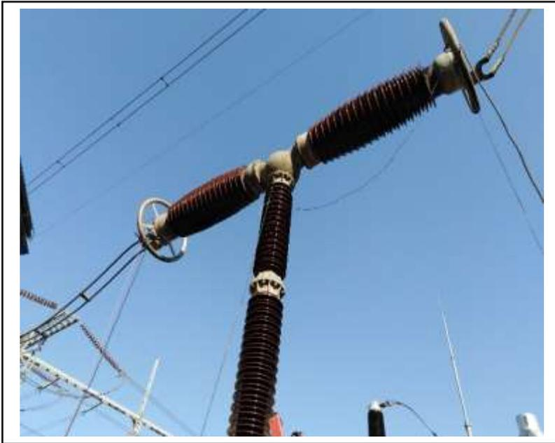
Figura 13: Disjuntor de alta tensão a gás SF6.
