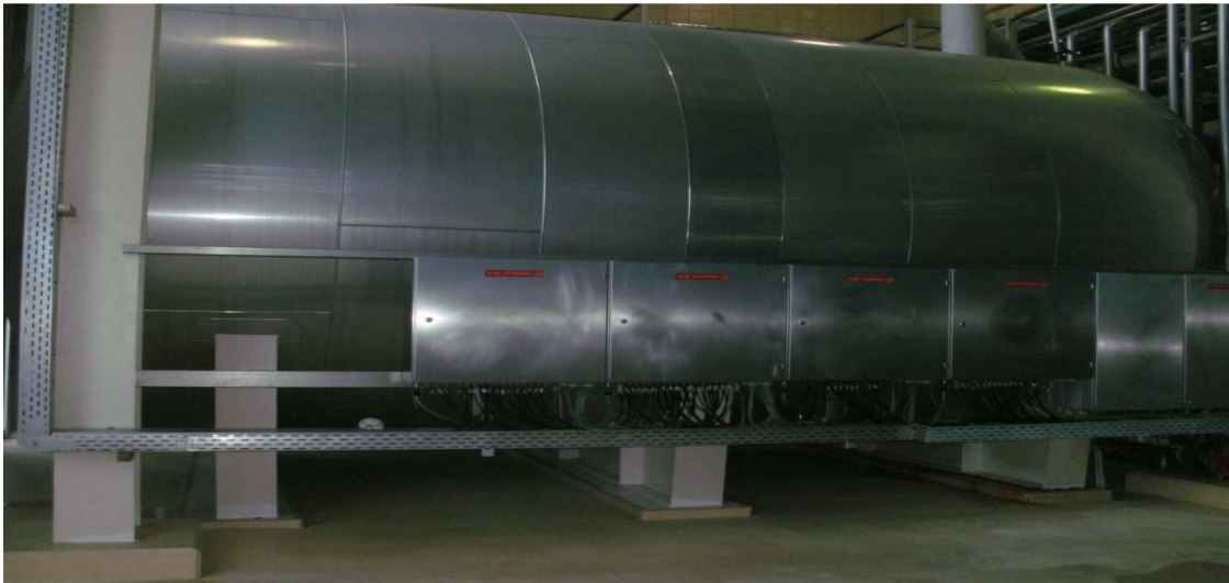
Tanque de espera ou tampão – onde se recolhe o mosto filtrado antes de ser transferido para a caldeira de ebulição.
