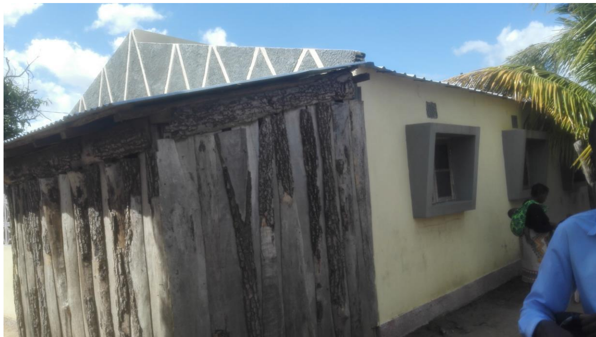
Figura 12: Casa de alvenaria
