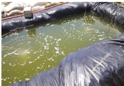
Figura 3: Tanque com paredes de sacos de areia e revestido com plástico usado no tratamento FI.
