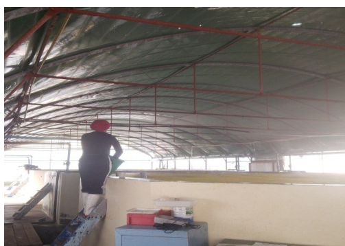
Figura 2: Tanque de betão usado no tratamento TB.
