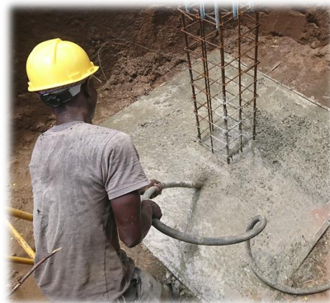
Figura 21: vibração do betão
