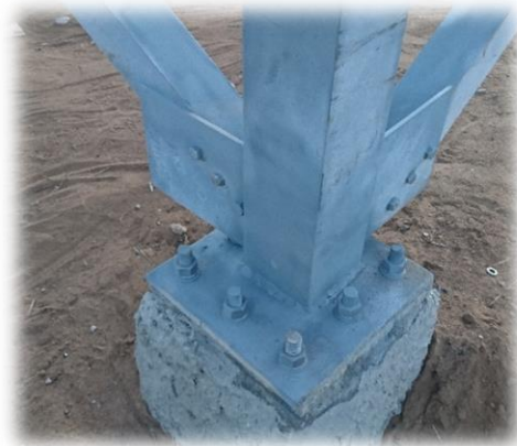
Figura 17: Soldadura em obra
