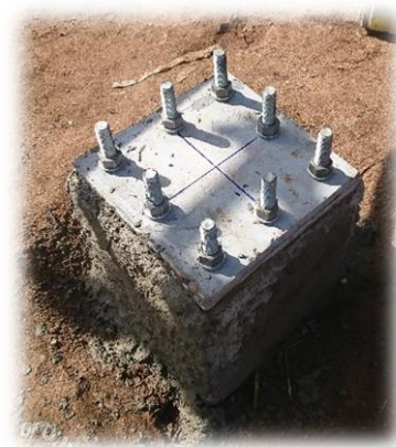
Figura 25: Chapas de ligação e chumbadores
