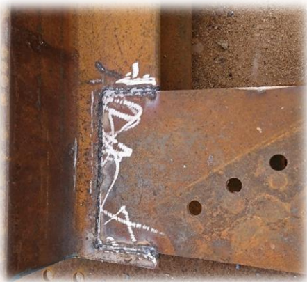
Figura 16: Soldadura em fábrica
