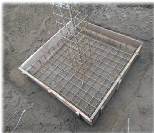
Figura 20: Cofragem da sapata
