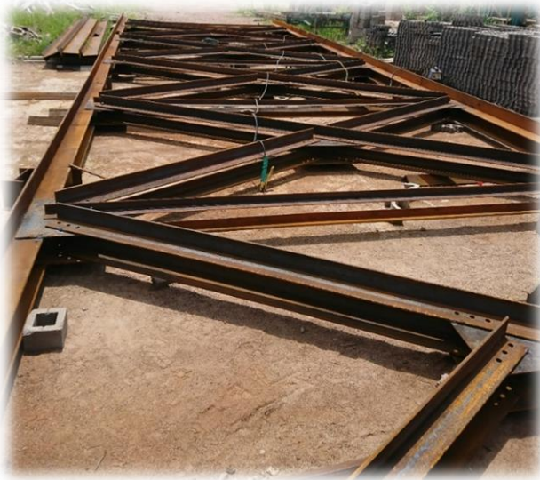
Figura 15: Pré-montagem em fábrica
