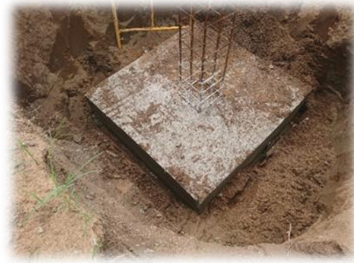
Figura 23: Descobragem da sapata
