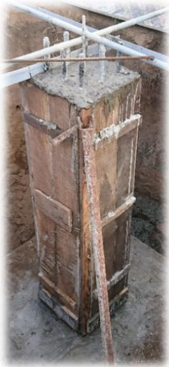
Figura 24: Pilar betonado e descobrado
