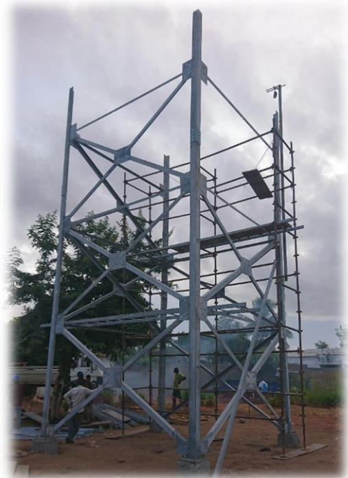
Figura 27: Montagem dos primeiros 6 metros e 9 metros, respectivamente.
