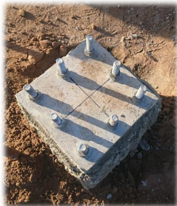
Figura 25: Chapas de ligação e chumbadores
