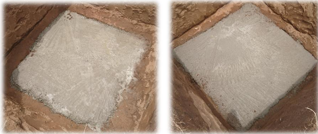
Figura 19: Betão de limpeza
