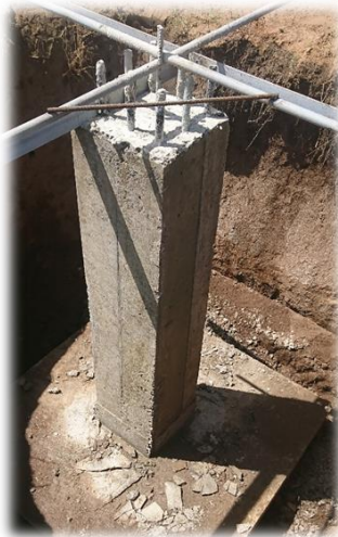
Figura 24: Pilar betonado e descobrado
