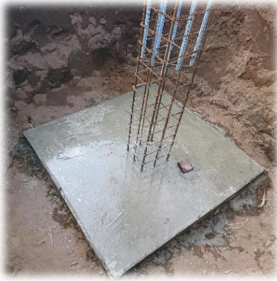
Figura 22: Sapata betonada
