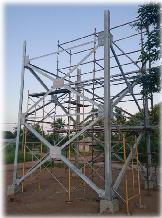
Figura 27: Montagem dos primeiros 6 metros e 9 metros, respectivamente.
