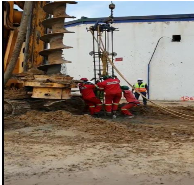
Figura 25: Introdução da armadura na estaca (fonte: Autor)
