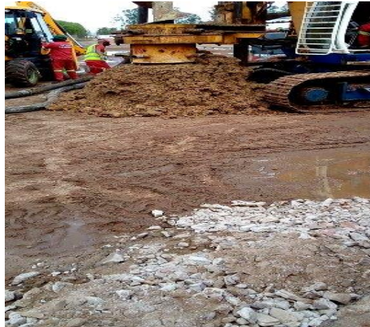
Figura 12: Início da furação do terreno (fonte:Autor)
