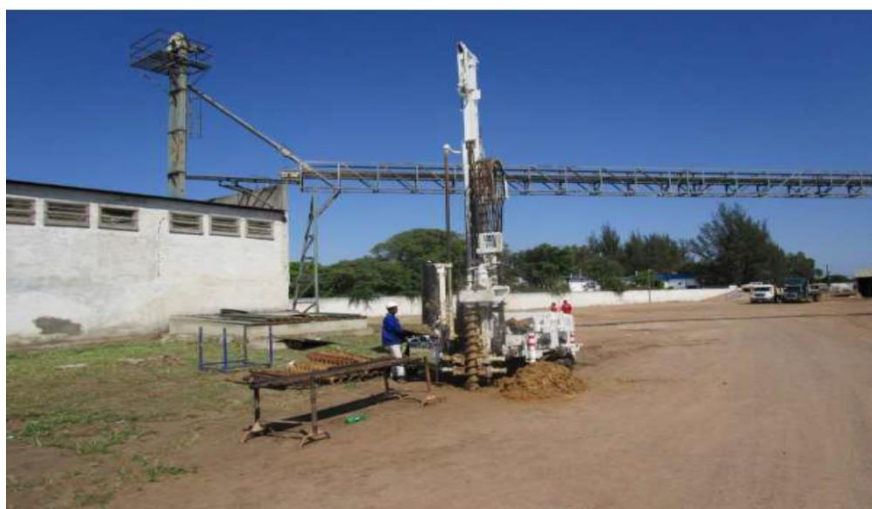
Figura 3: Equipamento da sondagem
