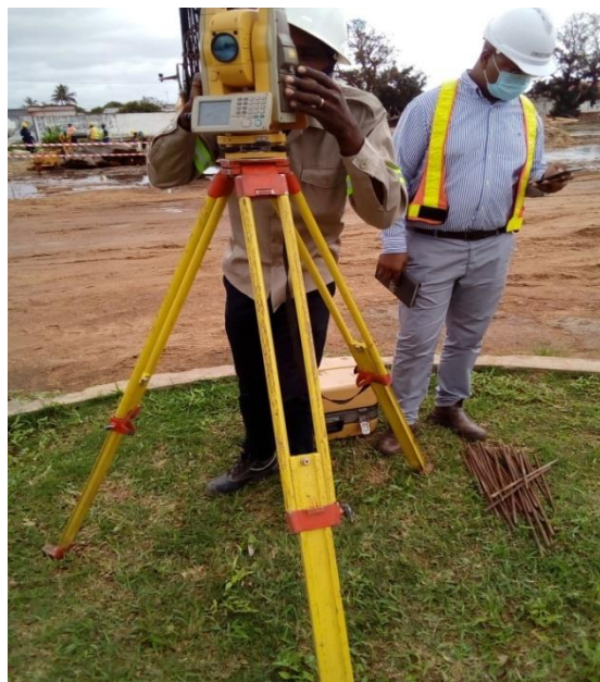
Figura 9: Implantação das estacas com recurso a serviços de topografia (fonte:Autor)
