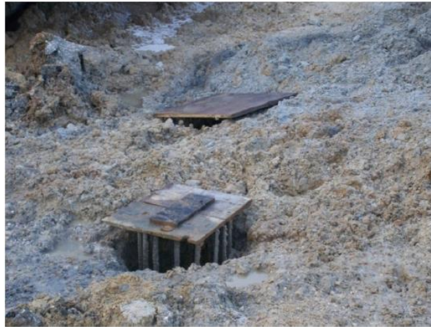
Figura 38: Painel de contraplacado marítimo na cabeça da estaca (fonte: Autor)
