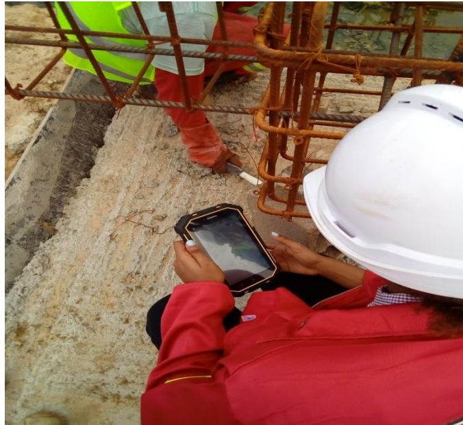
Figura 27: Aplicação de pancada com martelo na cabeça da estaca (fonte: Autor)
