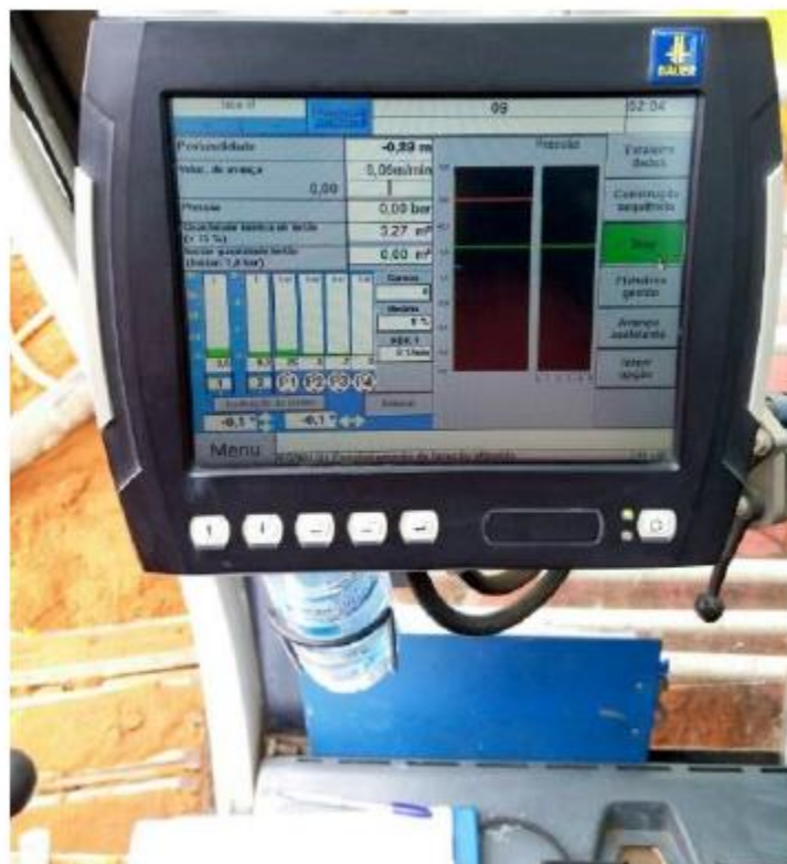
Figura 13: Perfuração para a Execução da Estaca pelo método (CFA) (fonte:Autor)
