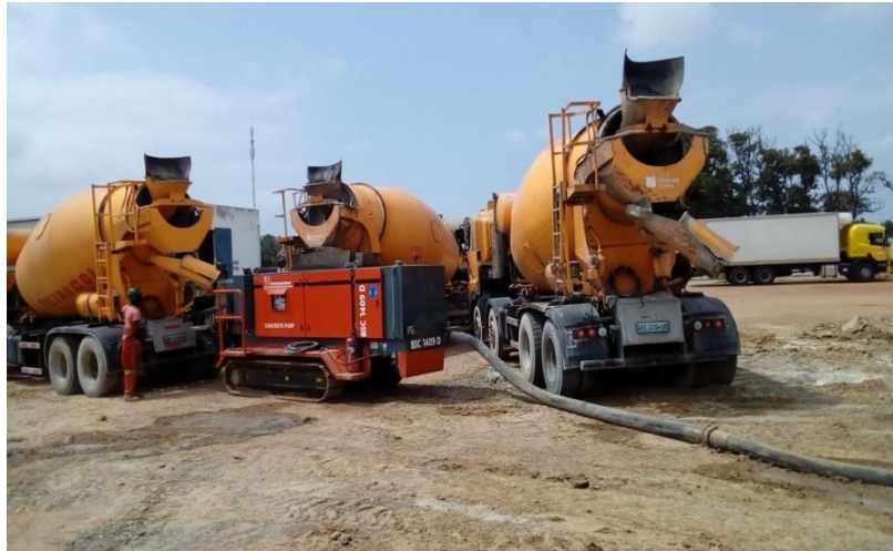
Figura 14: Equipamentos de fornecimento e de bombagem do betão (fonte:Autor)
