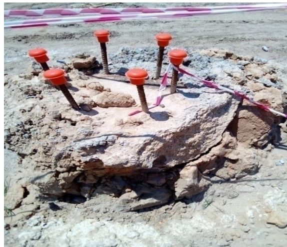
Figura 39: cogumelo de protecção para ferro (fonte: Autor)
