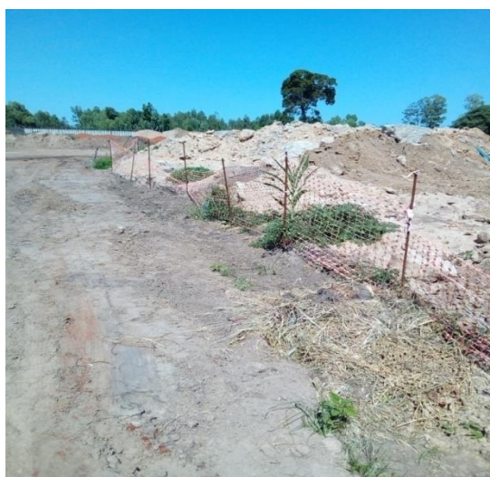
Figura 32: Delimitação de zonas de circulação pedonal (fonte:Autor)
