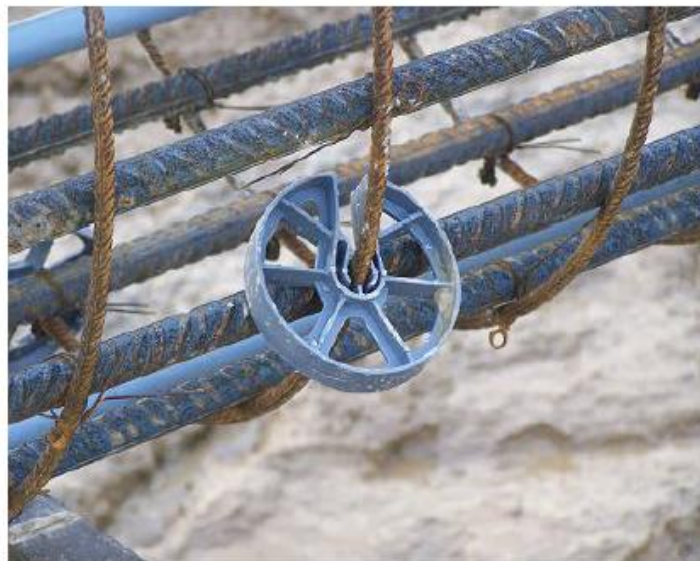
Figura 21: Armadura com os espaçadores (fonte: Autor)
