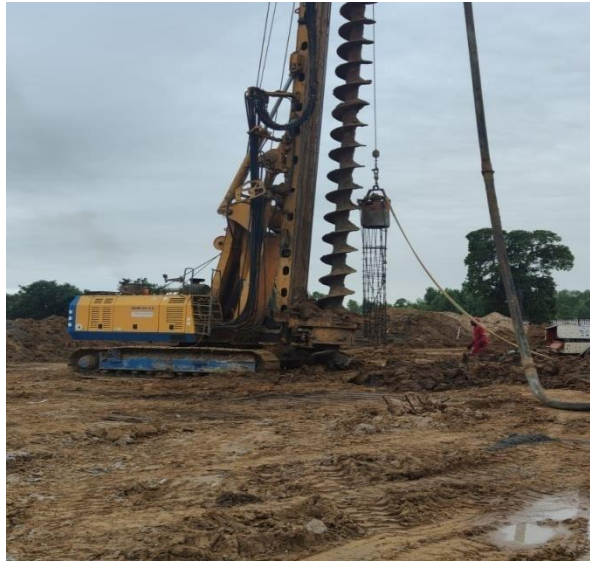
Figura 24: Verticalização e introdução da armadura no interior da estaca
