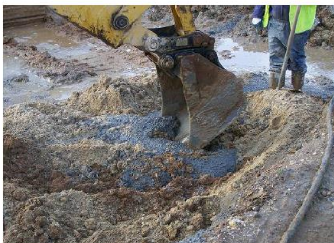
Figura 19: Remoção de detritos na cabeça da estaca (fonte: Autor)
