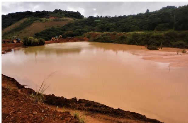
Figura 8 Bacia de retenção dos rejeitos
