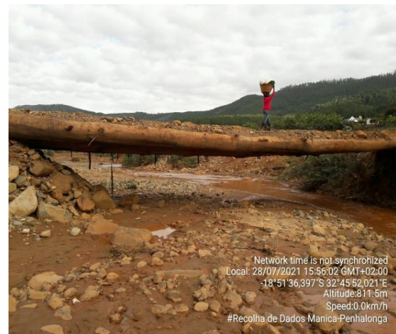
Fig.15 Ponte Rio Revué -18°51'36,397"S 32°44',49"E Alt. 811.5m Fonte Autor 28.07.21
