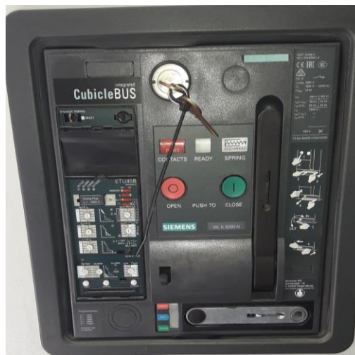
Figura 2: Exemplo de um disjuntor
