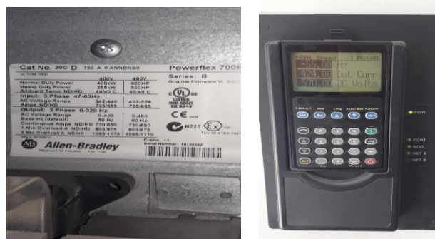
Figura 11: Especificações técnicas do arrancador Variador de frequência
