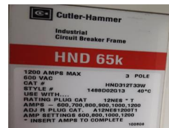
Figura 8: Especificações técnicas do disjuntor dos motores
