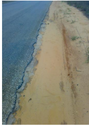
Fig. 13. Rachadura de borda Fig. 14. Elevação de berma Fig. 15. Rachadura em bloco
