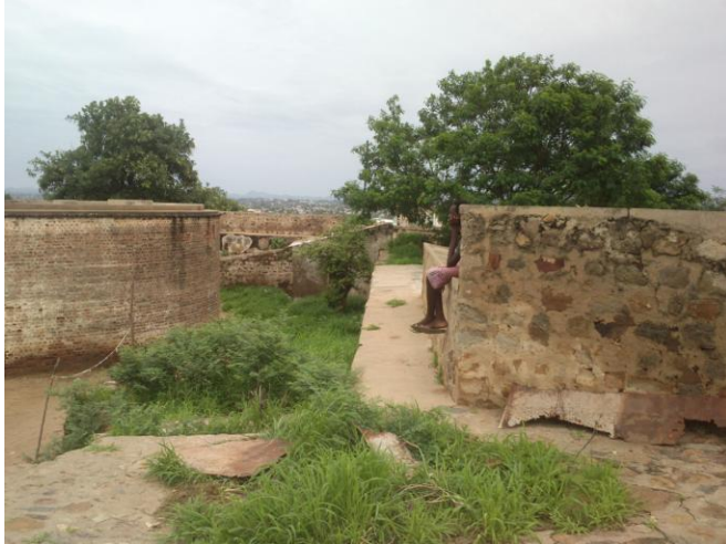
Figura 1. Ilustração da degradação de uma das torres cónicas do forte de Dom Luiz, Tete. Foto de: Fernando Chissale.
