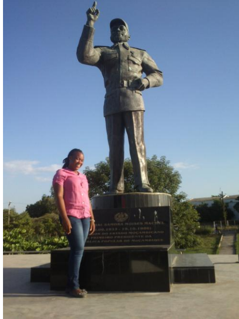
Figura 8. Alteração da cor e manchas causadas pela acção das de aves e da chuva. Foto: Fernando Chissale.
