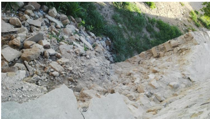
Figura 5. Retirada de pedras numa das fachadas do forte Dom Luiz para a construção de novas moradias. Foto: Fernando Chissale.
