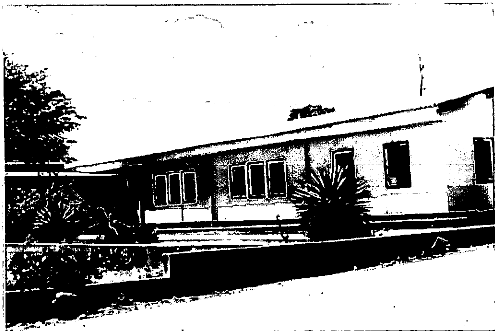
De cima para baixo: Foto 5 - Vista parcial do bairro residencial dos trabalhadores da Carbomoc; Foto 6 - Instalações do Centro Social e Cultural da Carbomoc.
