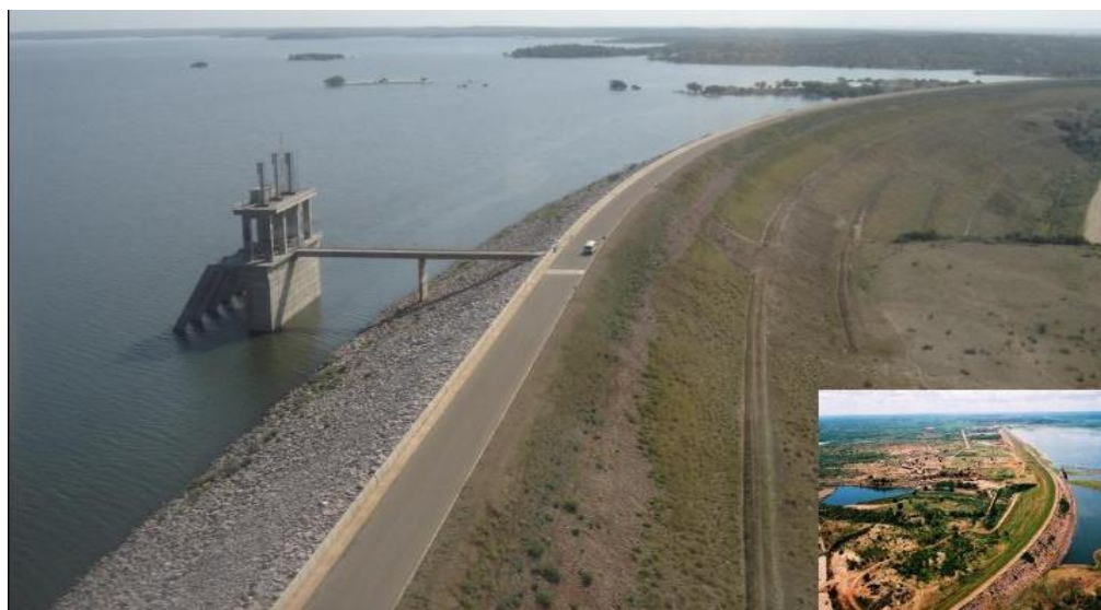
Figura 3: Barragem de Massingir (ARA-SUL, 2009)
