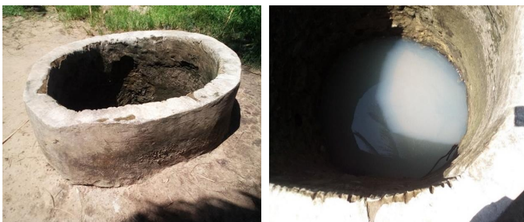
Figura 12- Poço a céu aberto no povoado de Mongué
