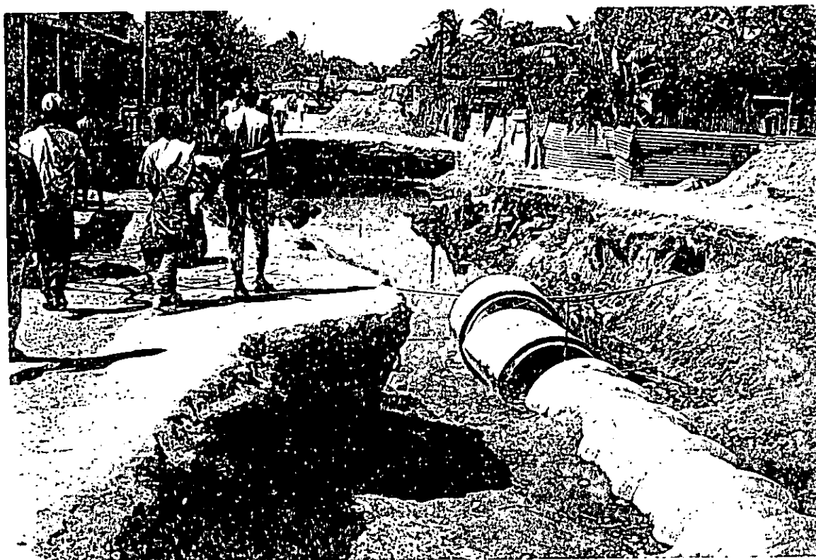
Figura nº2: Obras de reabilitação das vias de acesso dificultadas pelo lençol freático alto. (Instalação de um colector).
